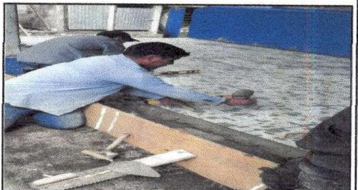
Foto 4: Sustitución de piso de torta de concreto por piso cemento líquido.
