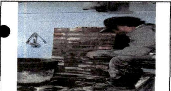
Foto 9: Sustitución de chimenea de concreto por chimenea de ladrillo.
